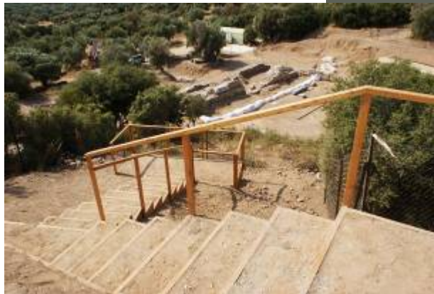
Διαμόρφωση πλατώματος θέασης
