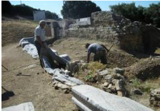
Εργασίες αλλαγής γεωκαλυμμάτων
