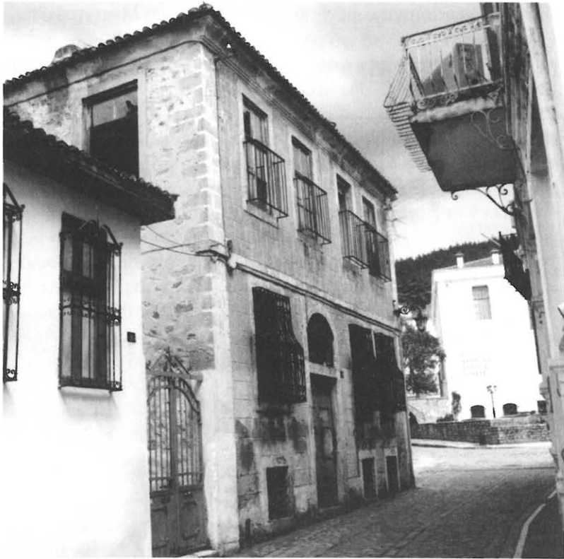
Σπίτι οδού Αντίκα αριθ.11 (το διώροφο κτίριο αριστερά)
